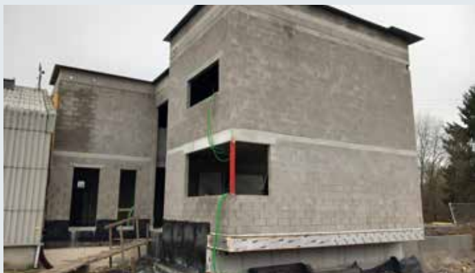
Les travaux continuent à l'atelier communal.
