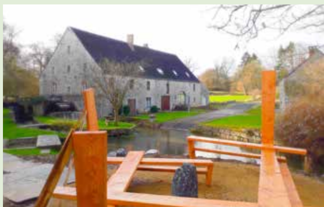
Installation d'une table pique-nique à Mohiville
