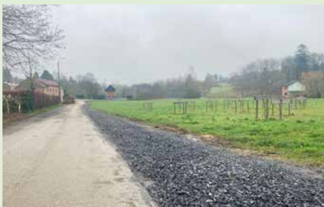
Réfection d'un accotement à Schaltin
