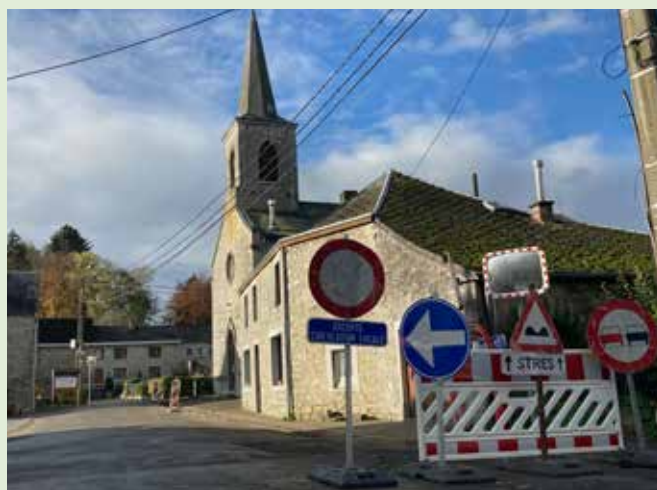
Travaux rue d'Achet
