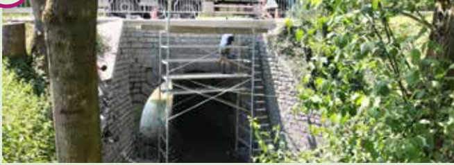
Rénovation du pont à Natoye à proximité de la Spirale
