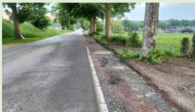
Travaux de réhabilitation de la zone piétonne et cycliste - Chaussée de Namur à Natoye.
