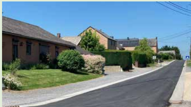
Pose de filet d'eau. Réfection de voirie rue des Papillons à Schaltin.
