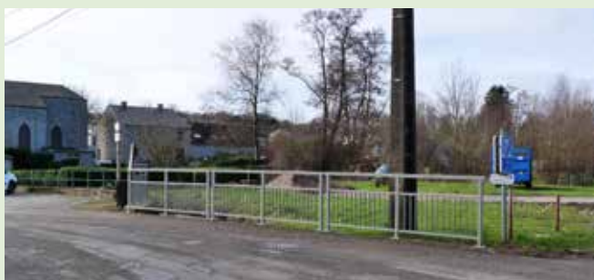
Installation par les agents communaux d'une nouvelle barrière sur le Bocq à Achet.
