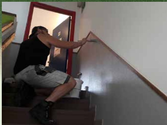
Travaux de peinture à l'école communale de Schaltin
