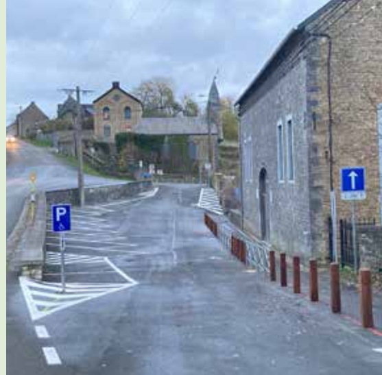
Aménagement d'un espace parking et de sécurité aux abords de l'EPSIS
