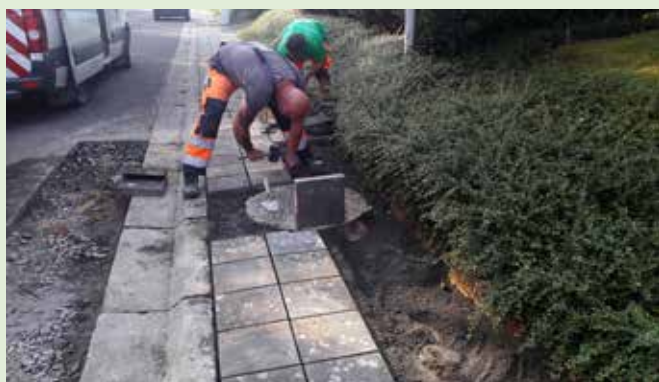
Réfection d'un trottoir à Natoye
