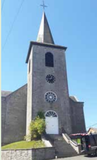
Église de Schaltin, remise en état de la porte principale
