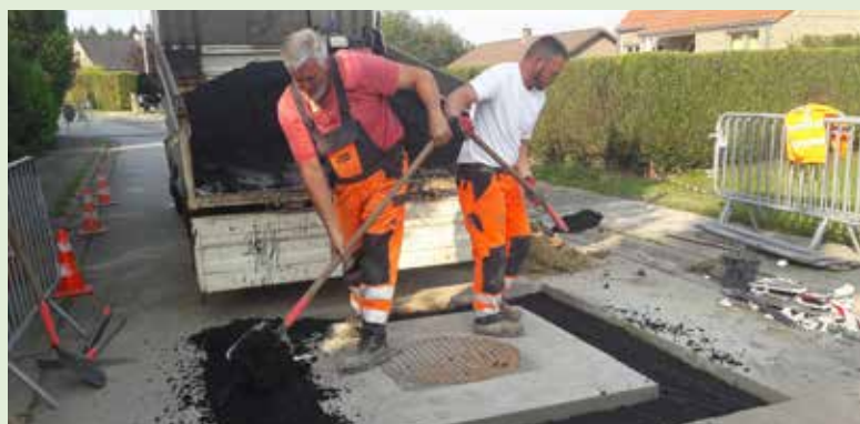
Réfection d'une taque d'égout à Natoye
