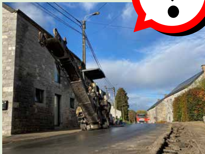
Travaux rue d'Achet
