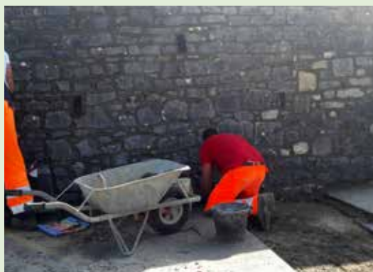
Réfection d'un mur au cimetière de Mohiville
